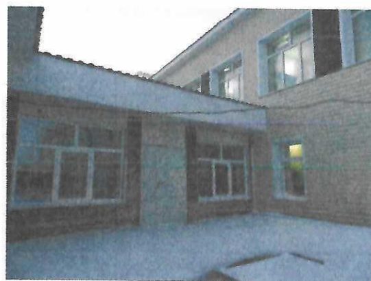
Фасады здания на момент обследования. Установлены места с трещинами штукатурного декоративного слоя стен и вновь оштукатуренные их участки Трещины носят локальный характер и не являются значимыми
