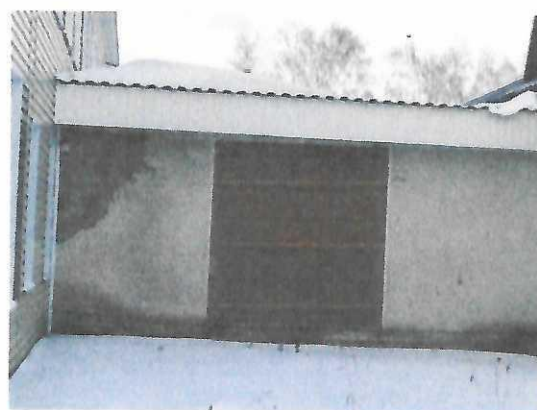
Фасады здания на момент обследования. Установлены места с трещинами штукатурного декоративного слоя стен и вновь оштукатуренные их участки Трещины носят локальный характер и не являются значимыми
