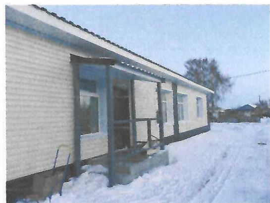
Фасады здания на момент обследования. Техническое состояние отмостки работоспособное
